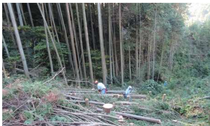
▲送電線線下伐採作業
